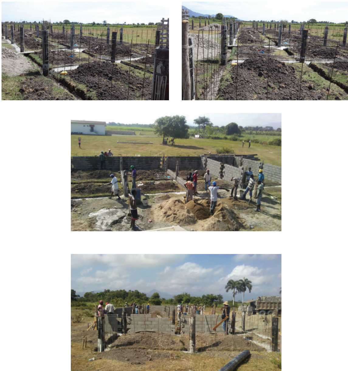
Figure 13 Fondation sur pieux de l'école fondamentale – Phase 1
