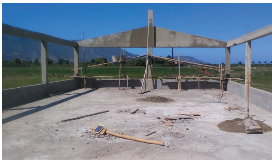
Figure 19 Construction de la superstructure du poulailler
