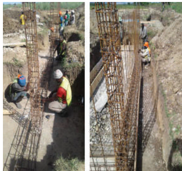
Figure 16 Travaux de fondations – Armatures des fondations
