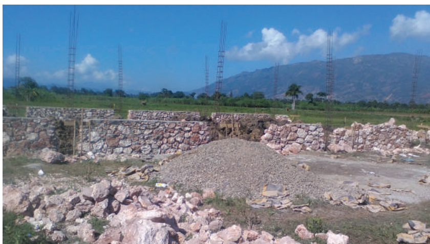
Figure 18 Fondations du poulailler
