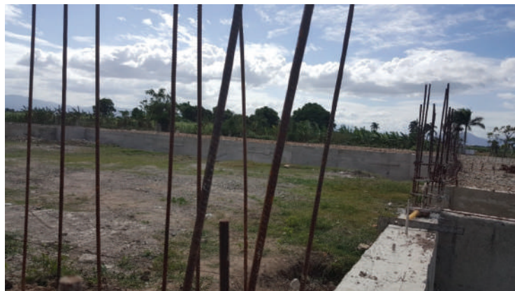
Figure 17 Fondations surélevées pour parer aux inondations
