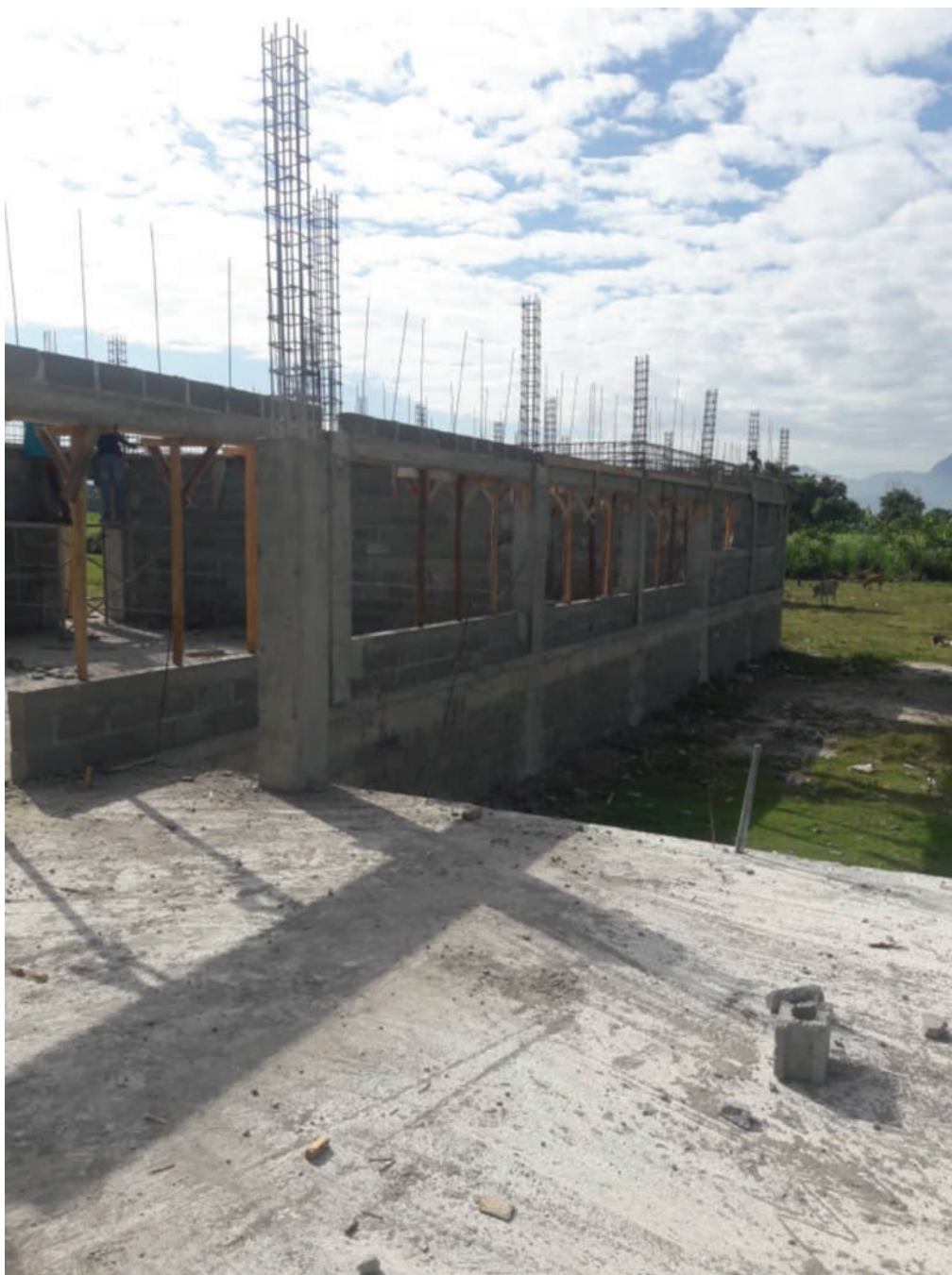
Figure 14 Vue du bâtiment surélevé et à l'abri des inondations
