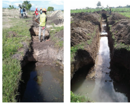
Figure 15 Travaux de fondations – Fouille des tranchées
